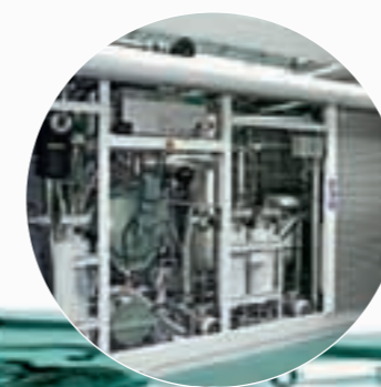
Bei beengten Platzverhältnissen am Aufstellort: Wartungszugang via Rollladen
